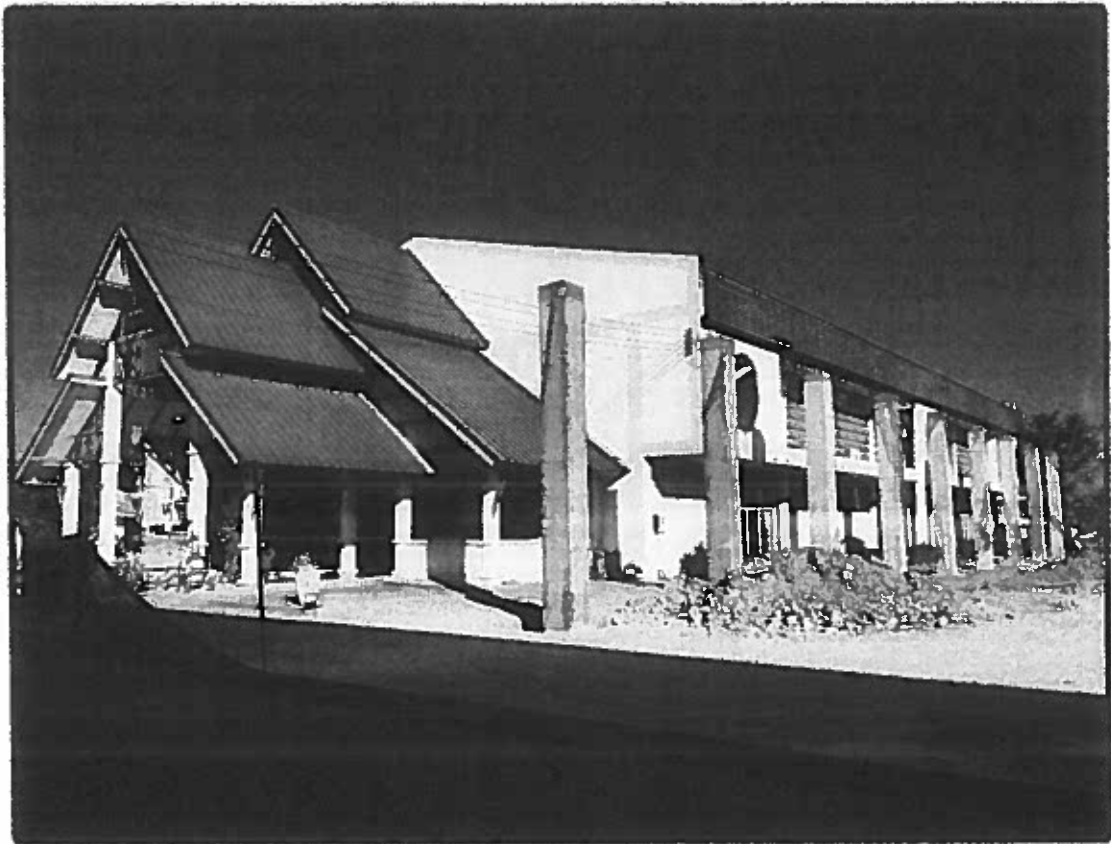
โครงการก่อสร้างหลังคาโดม (ด้านหลังสำนักงานเทศบาลตำบลหางดง) หมู่ที่ ๓ (อยู่ระหว่างดำเนินการ)
