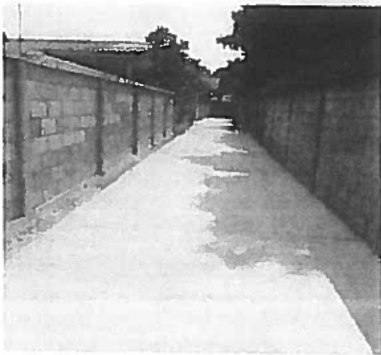
ภาพก่อสร้างแล้วเสร็จ
