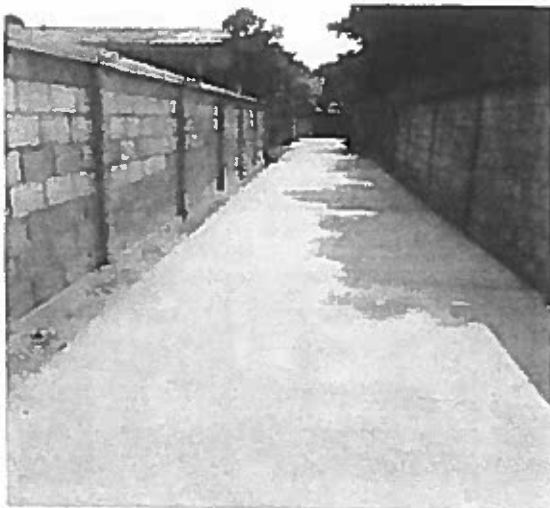
ภาพก่อสร้างแล้วเสร็จ
